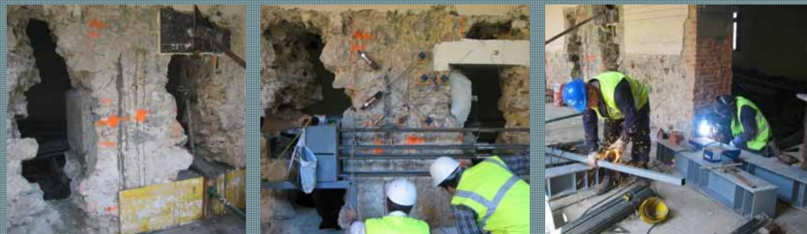
Los **ensayos, a rotura**, se están ejecutando **tanto en la mampostería existente, como en dicha fábrica reforzada con microhormigón y barras de FRP (polímeros reforzados con fibra de vidrio) y mediante refuerzos convencionales de acero**. El objetivo fundamental es conocer tanto la capacidad mecánica de la mampostería involucrada como la alcanzada con dichas técnicas de refuerzo (permitiendo la comparación de las mismas) y, como ya se ha referido, frente a diferentes solicitaciones.
